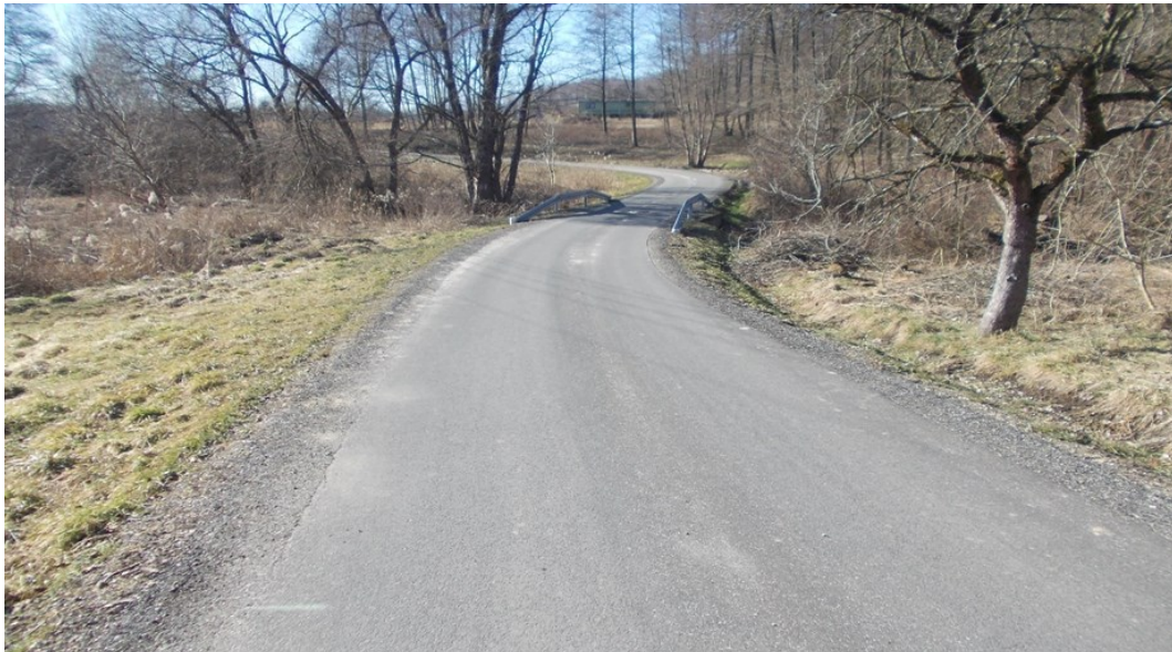
Rysunek 5 Przebudowa ul. Lipowej w Markłowicach Górnych
