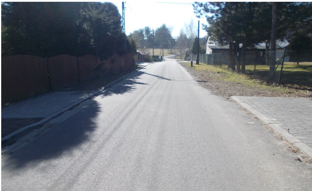
Rysunek 12 Przebudowa ul. Słowiczej w Zebrzydowicach
