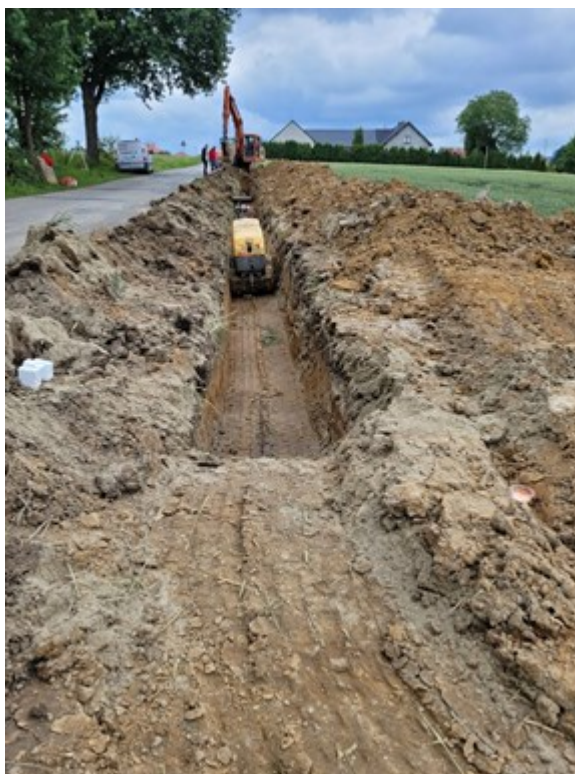
Rysunek 1 Zagęszczanie wykopu po ułożeniu kanalizacji sanitarnej - ul. Folwarczna
