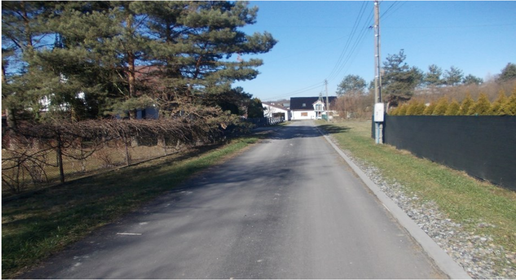
Rysunek 6 Przebudowa drogi gminnej - bocznej od ul. Dębowej w Markłowicach Górnych
