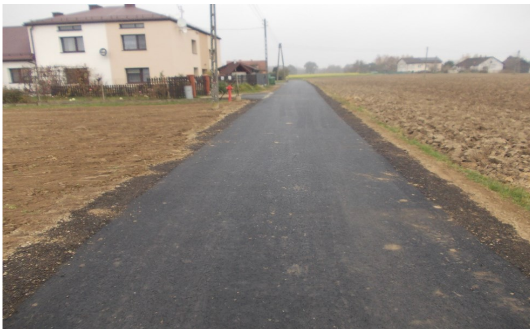
Rysunek 14 Przebudowa drogi bocznej od ul. Chabrowej w Zebrzydowicach
