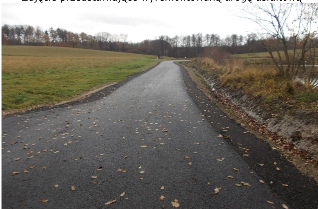
Rysunek 15 Przebudowa ul. Kalinowej w Zebrzydowicach
