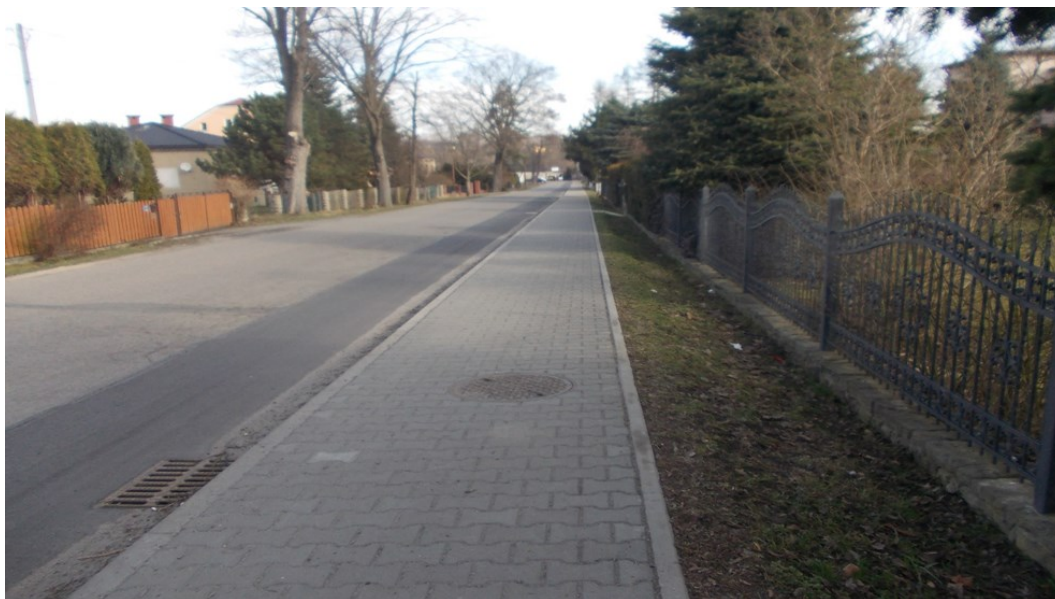
Rysunek 13 Przebudowa chodnika przy ul. Kasztanowej w Zebrzydowicach
