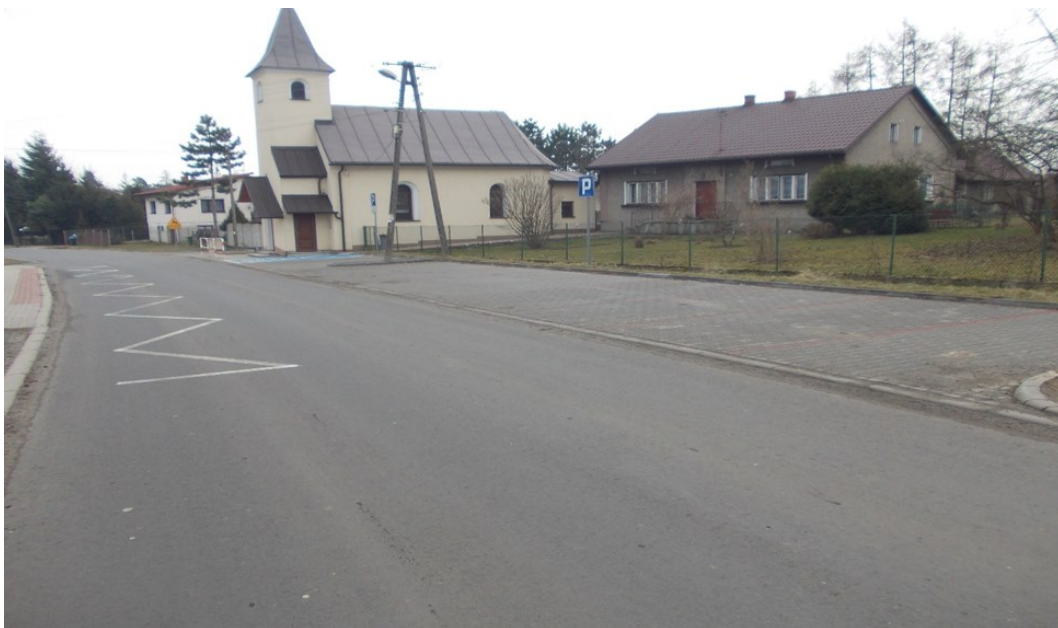
Rysunek 11 Budowa miejsc postojowych przy ul. Tuwima w Kaczycach
